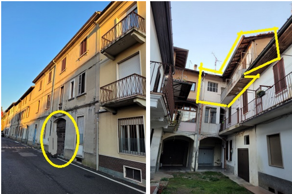
Vista Fabbricato p.2 - Ingresso ai piani e area esterna
