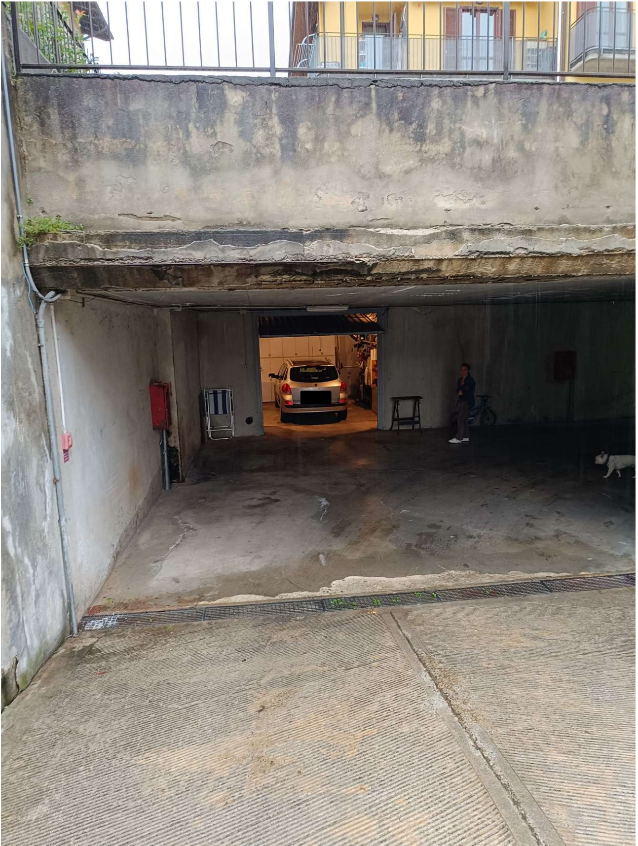
Rampa di accesso ai box con vista del box
