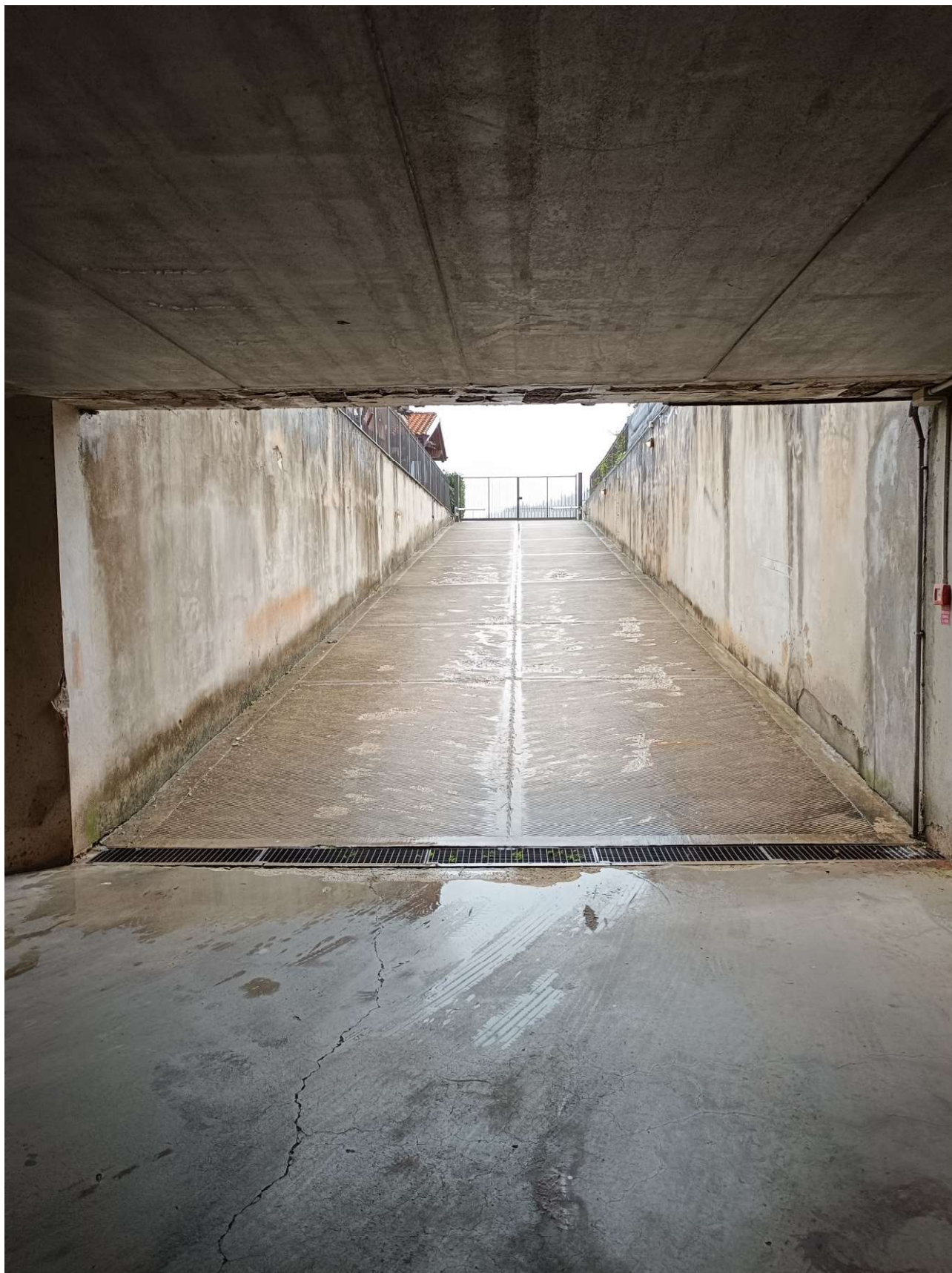
Rampa di accesso ai box
