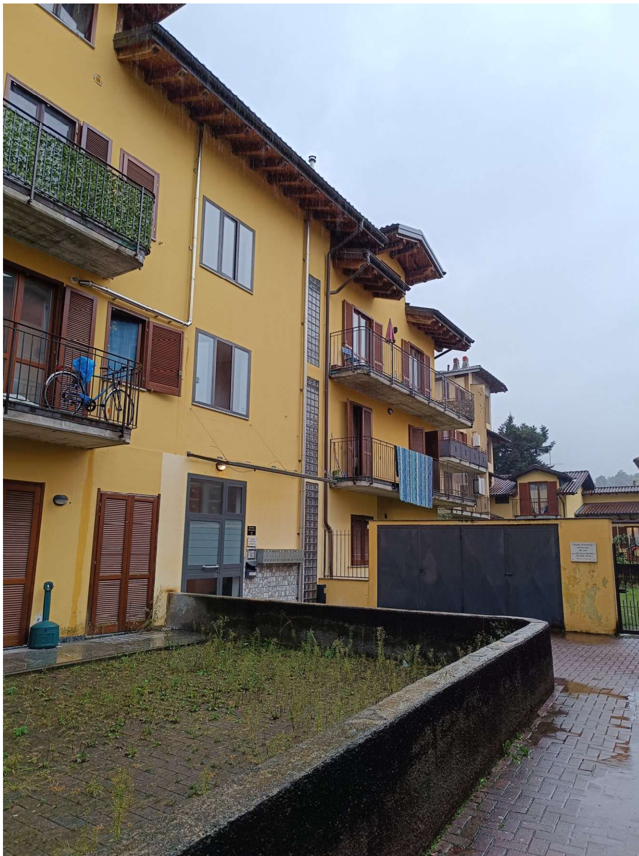
Vista del condominio dal cortile comune lato nord
