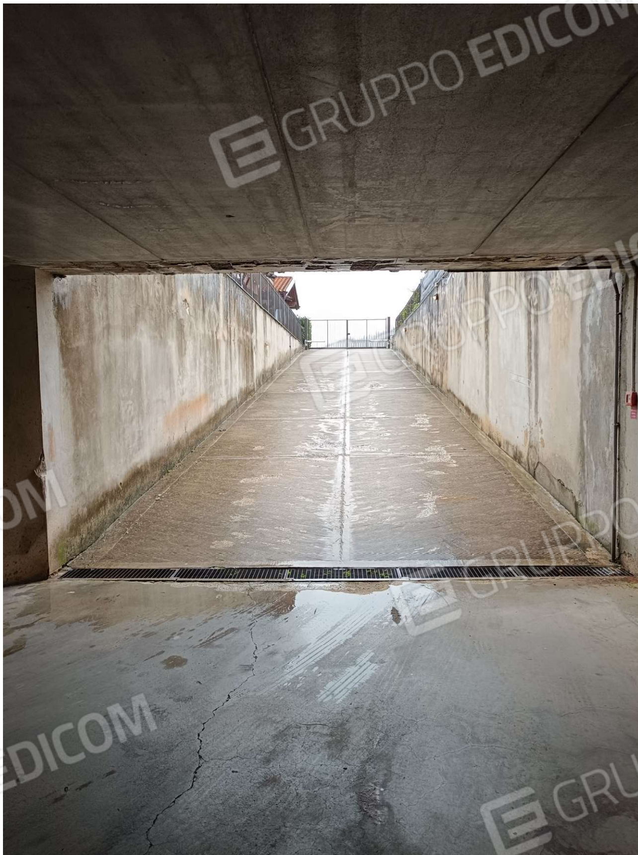
Rampa di accesso ai box
