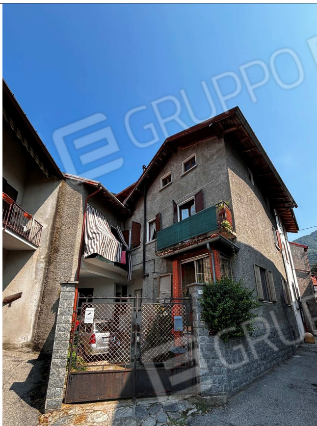
FOTO 02_FACCIADE SUD-OVEST CON ACCESSO AL P.T.
