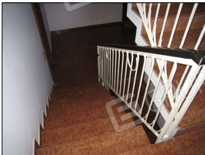
FOTO 9 VISTA DEL VANO SCALA CONDOMINIALE.
