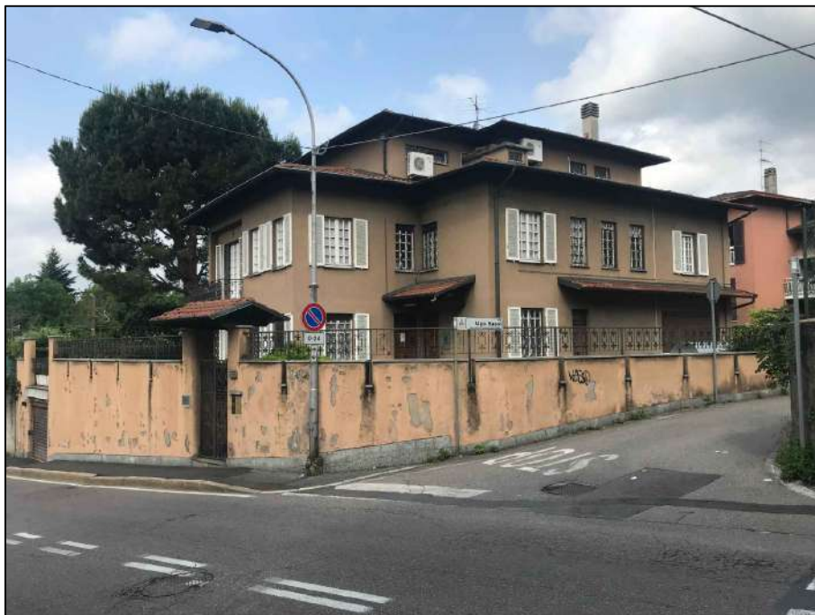
Foto 4 - VISTA FABBRICATO DA EST
