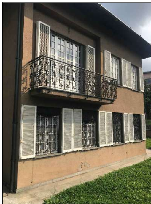
Foto 8 - VISTA FABBRICATO DA SUD
