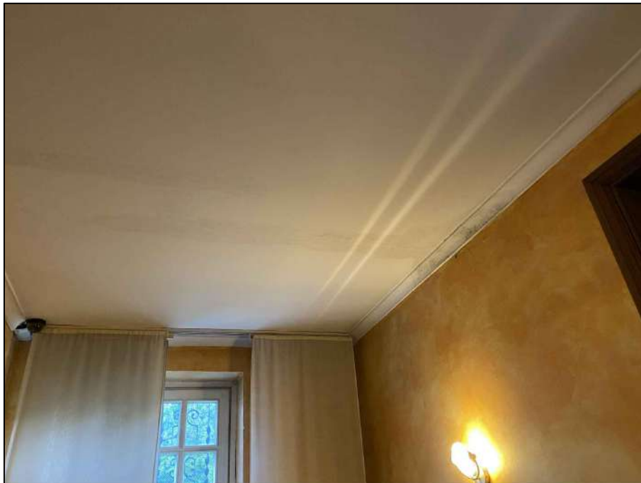
Foto 35 - DETTAGLIO SOFFITTO INGRESSO
