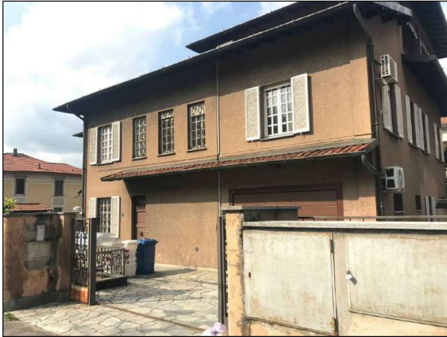
Foto 5 - VISTA FABBRICATO DA EST
