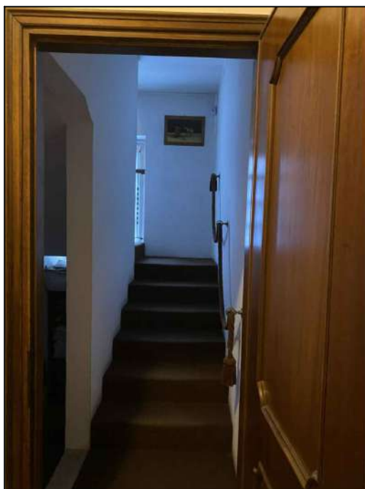
Foto 68 - SCALA VERSO PIANO SECONDO - LOTTO 003/A
