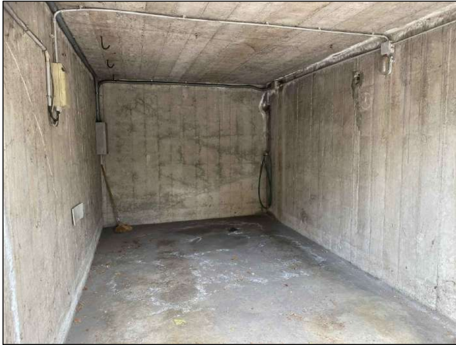
Foto 15 - BOX - LOTTO 003/B, INTERNO
