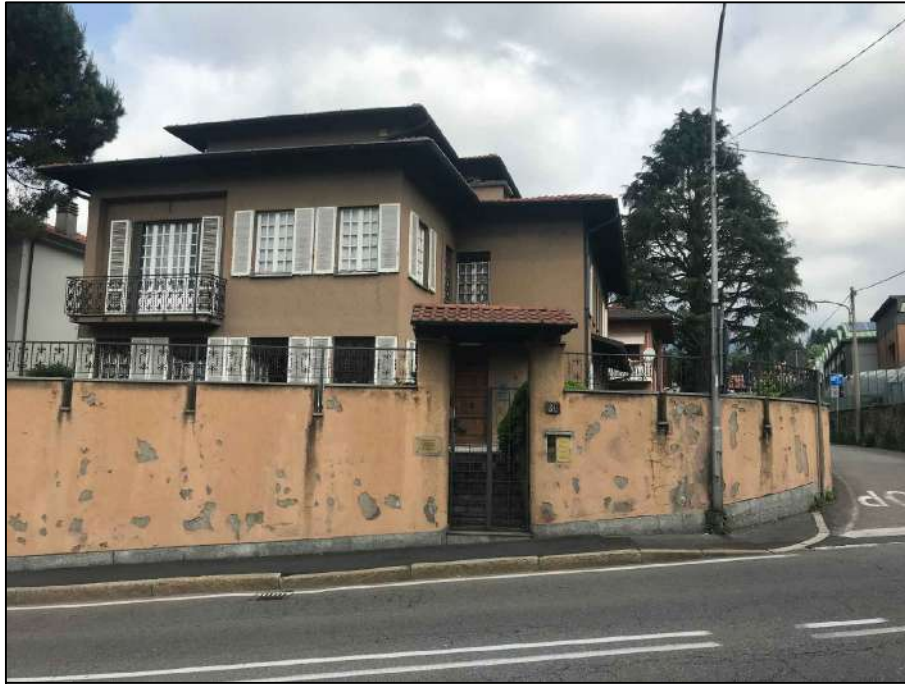
Foto 3 - VISTA FABBRICATO DA VIA E.TRENTINI, CANCELLETTO INGRESSO PEDONALE
