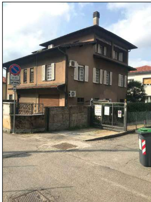
Foto 6 - VISTA FABBRICATO DA NORD-EST
