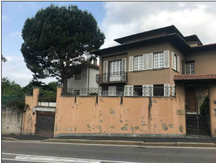
Foto 2 - VISTA FABBRICATO DA VIA E. TRENTINI
