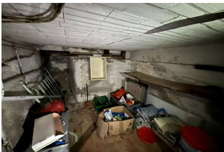
cantina Piano interrato
