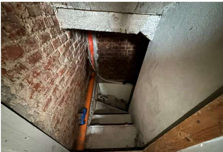
Scala di accesso piano interrato
