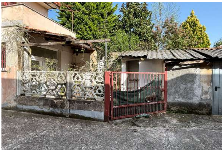
foto Esterni - accesso dal cortile e fabbricato accessorio esterno
