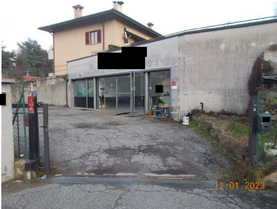
Foto 2 LOTTO 001 LOTTO 002 Area esterna e ingressi ai lotti
