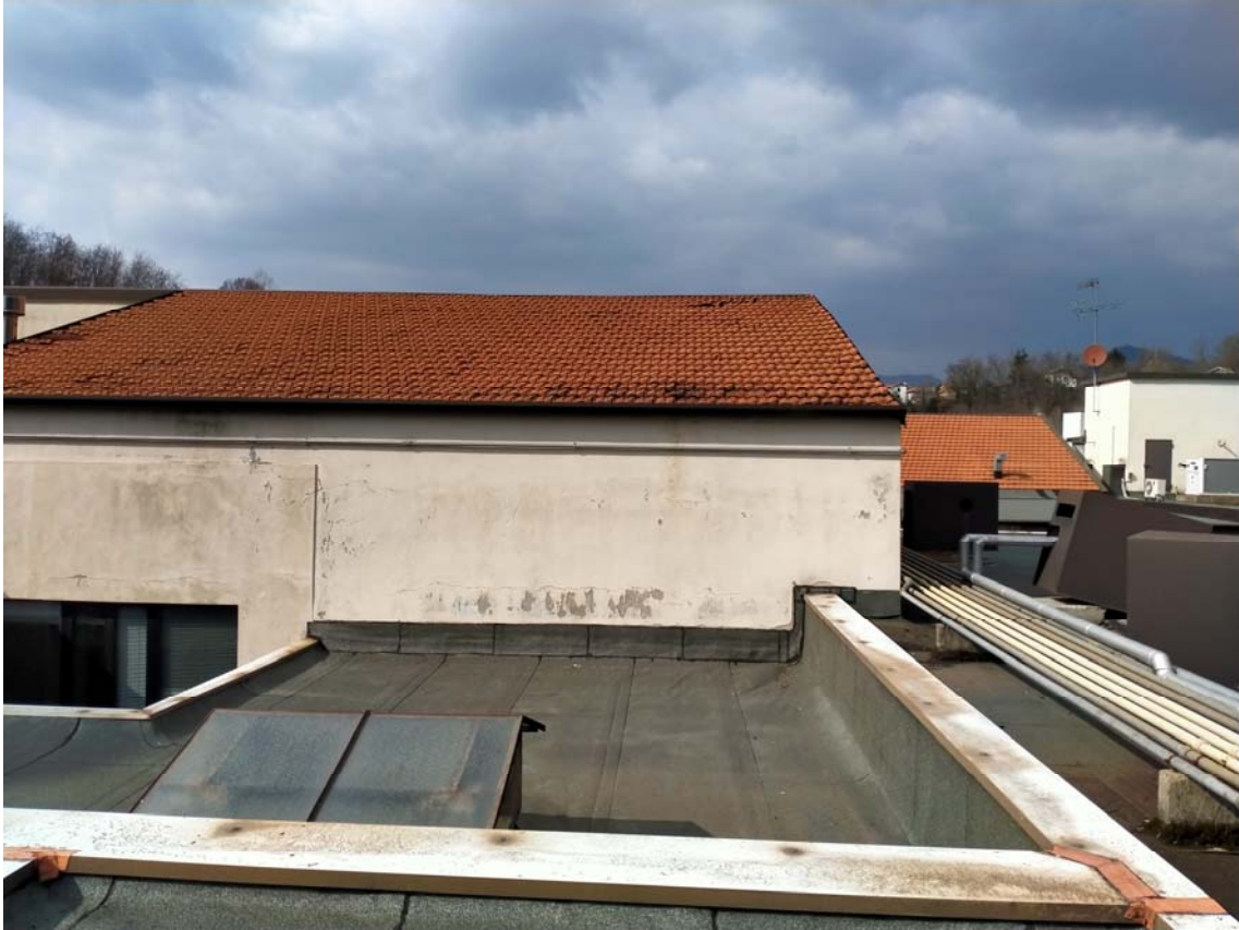
VISTA ESTERNA RIPOSTIGLIO P. 2°
