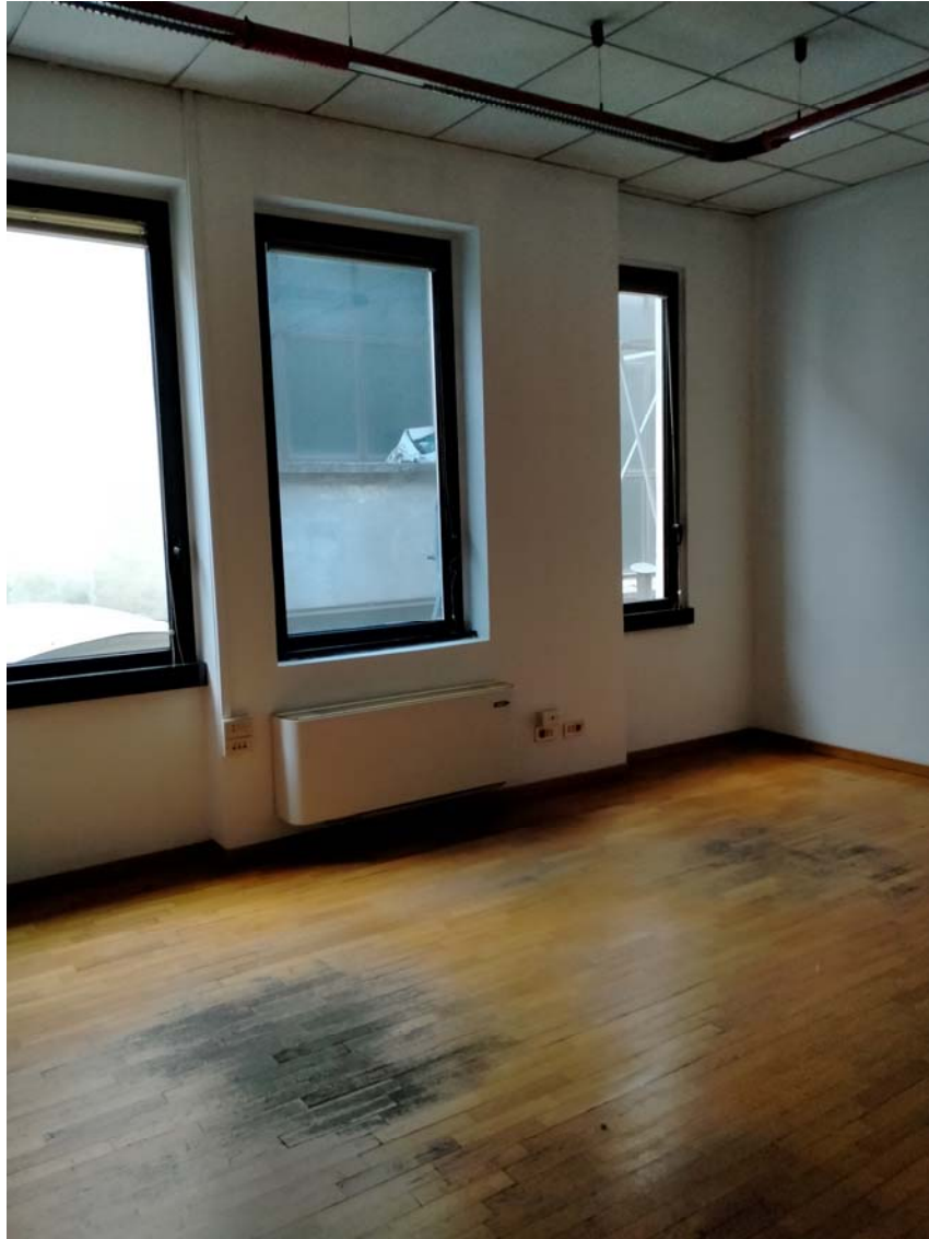
VISTA INTERNA UFFICI
