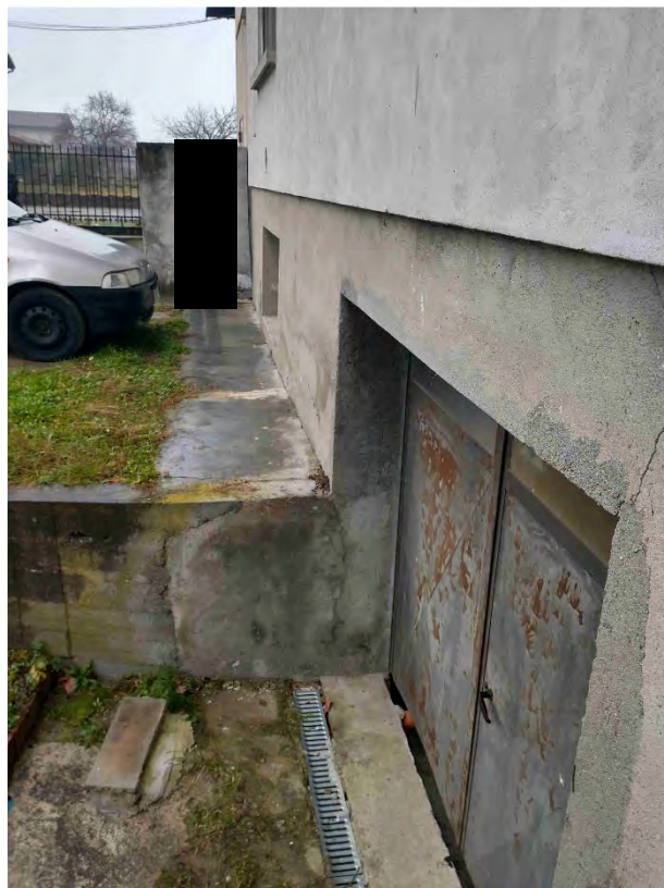
Esterno – accesso alla cantina P.S1
