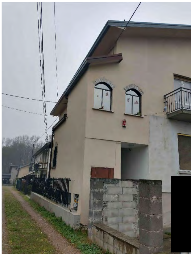
Vista esterna- lato Sud-Est
