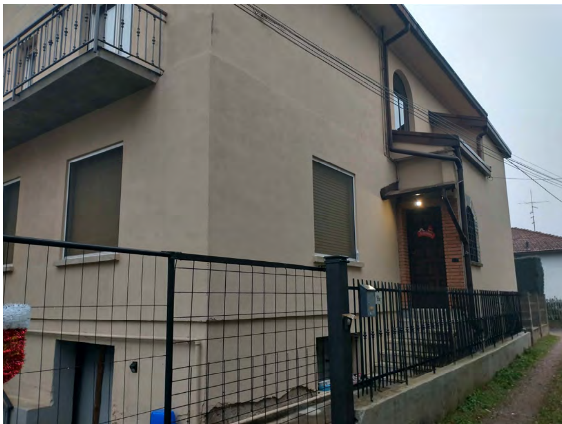
Vista esterna – lato Sud-Ovest (ingresso prop.Sig.Pascalis)
