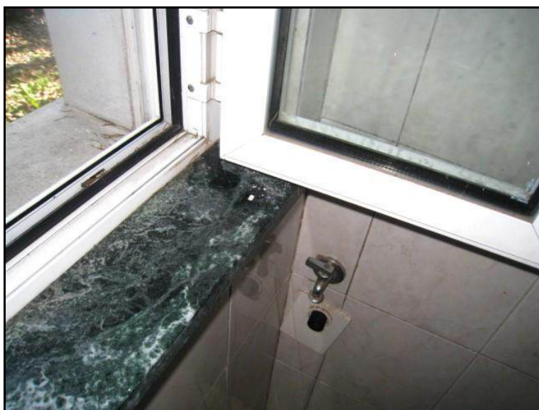
FOTO 12 VISTA PARTICOLARE SERRAMENTO FINESTRA DEL BAGNO
