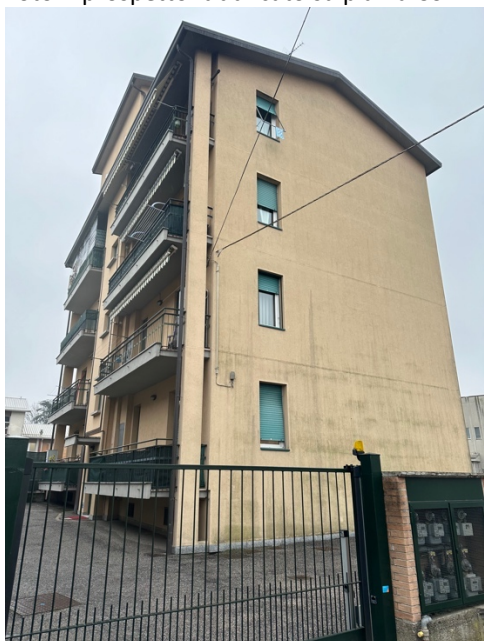
Foto 4-prospetto retro fabbricato accesso carraio
