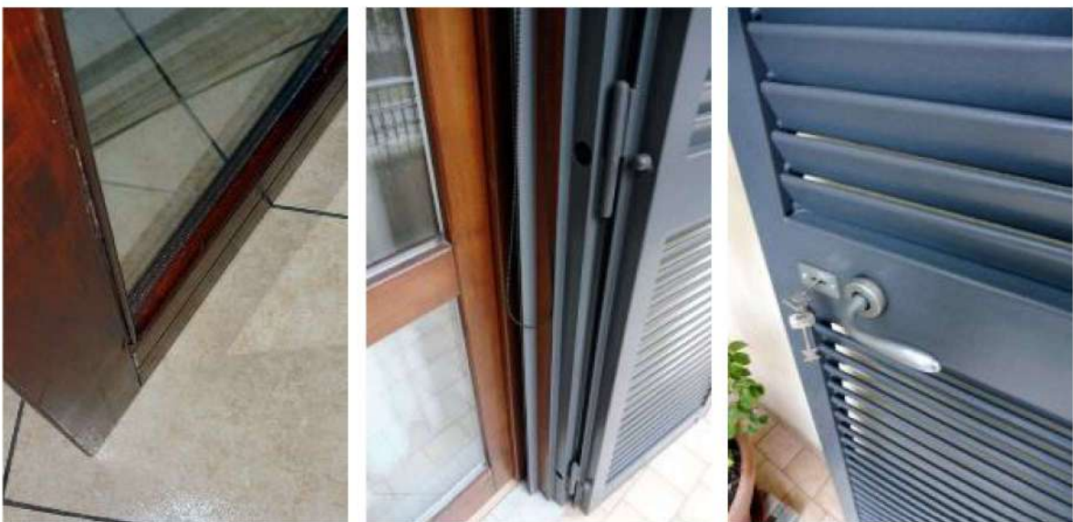
_dettagli: infissi con vetrocamera e veneziane in ferro con lamelle fisse
