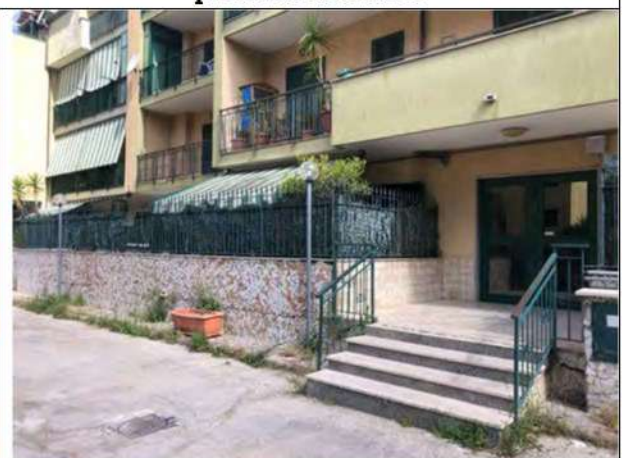
Fotografia n. 4 _ Ingresso al fabbricato B
