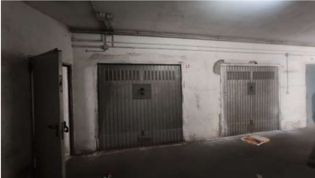
VISTA ESTERNA DEL BOX
