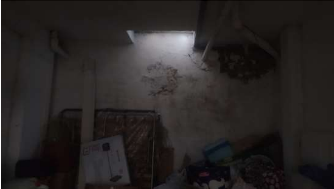
ALTRA VISTA INTERNA
