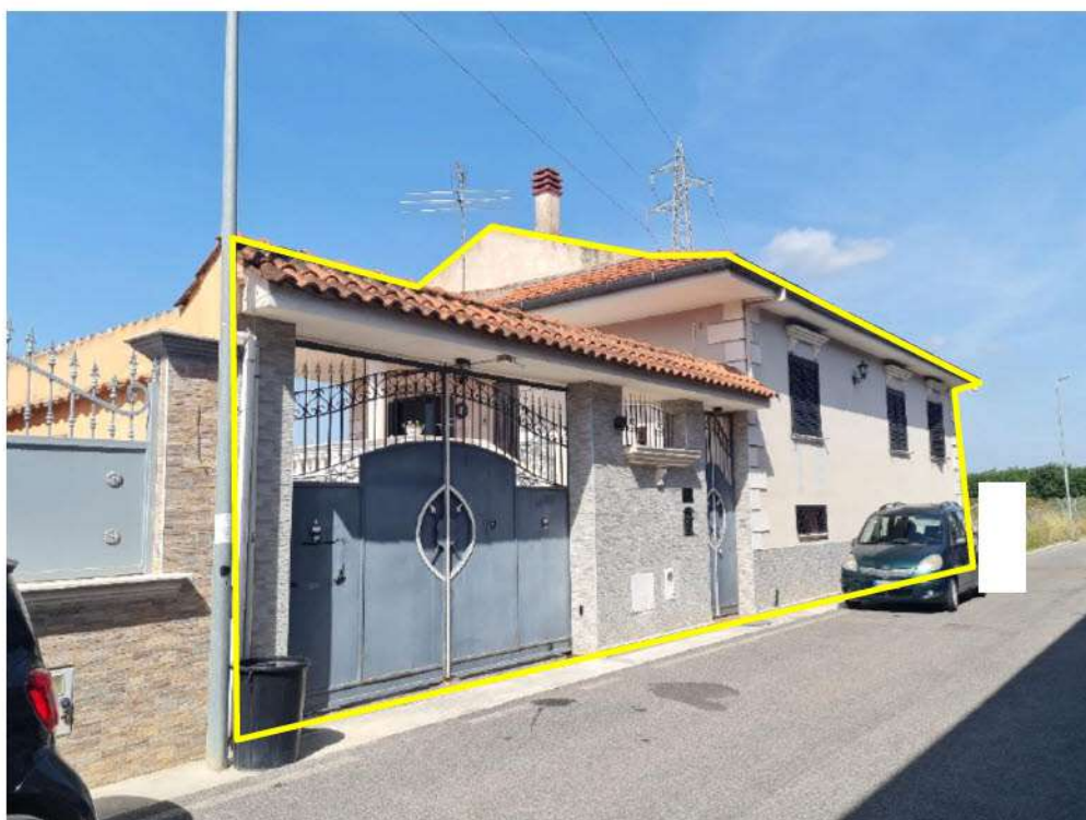
Strada di accesso, cancelli carrabile e pedonale
