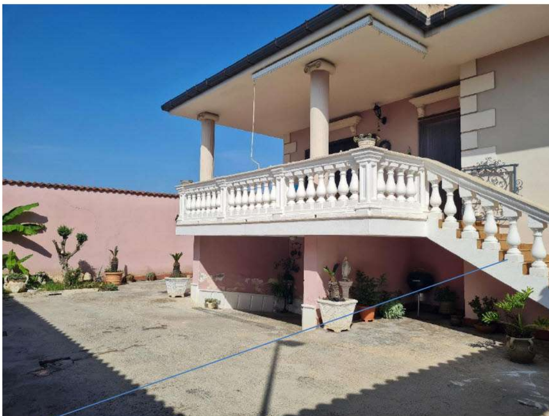
Rampa di accesso al piano rialzato
