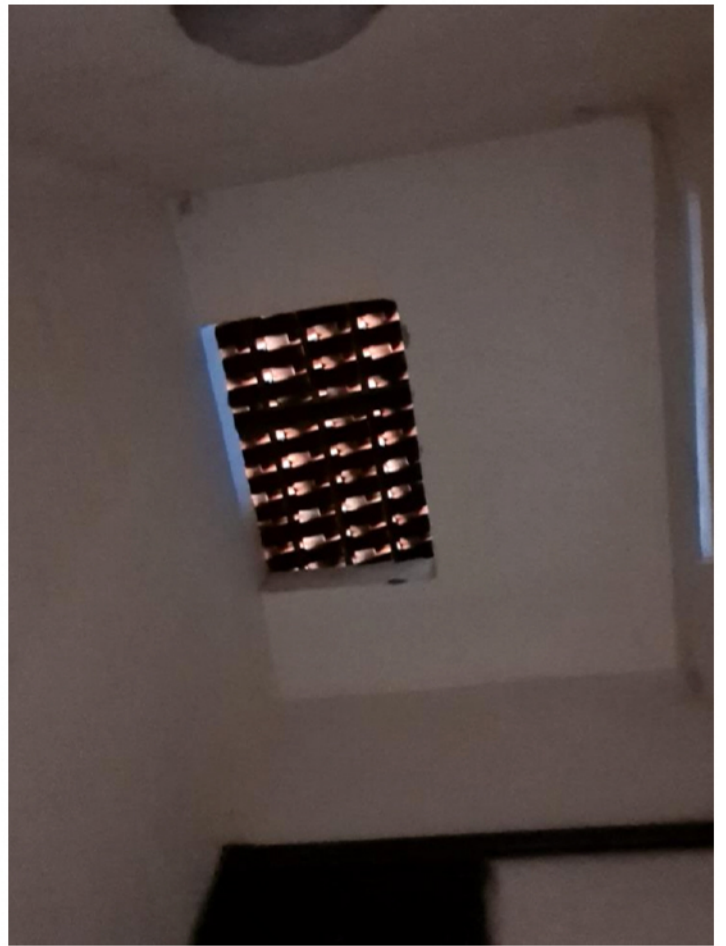
botola di accesso al sottotetto
