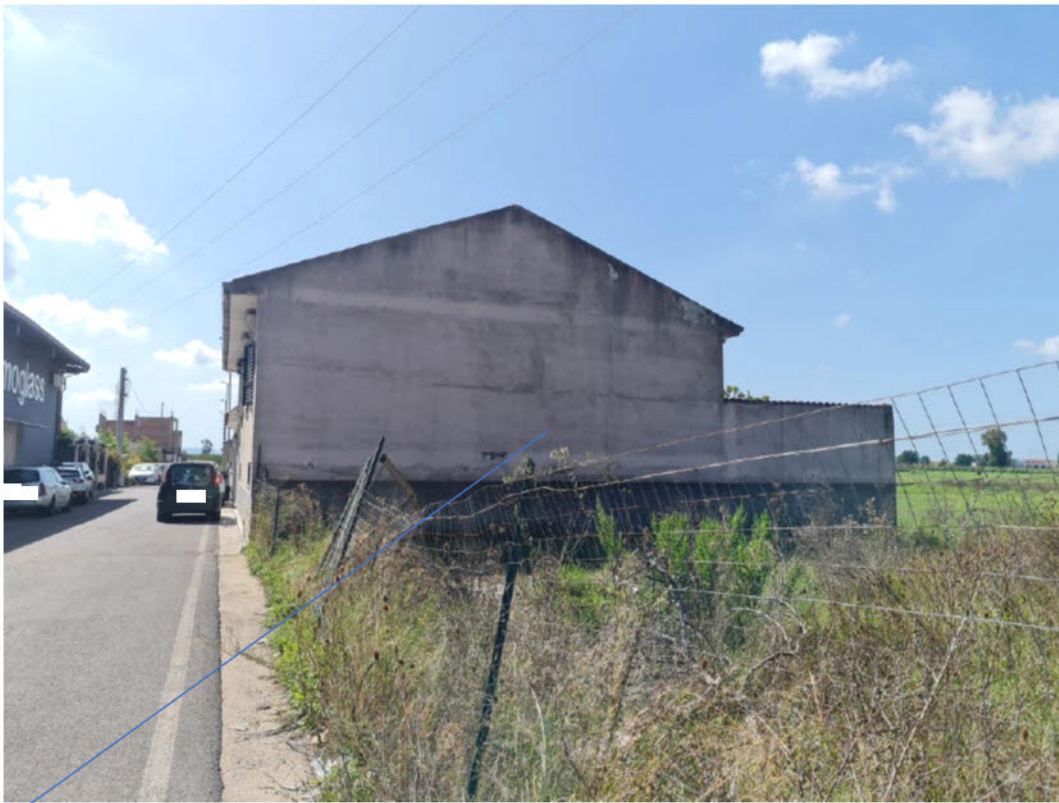
Vista del corpo di fabbrica da sud
