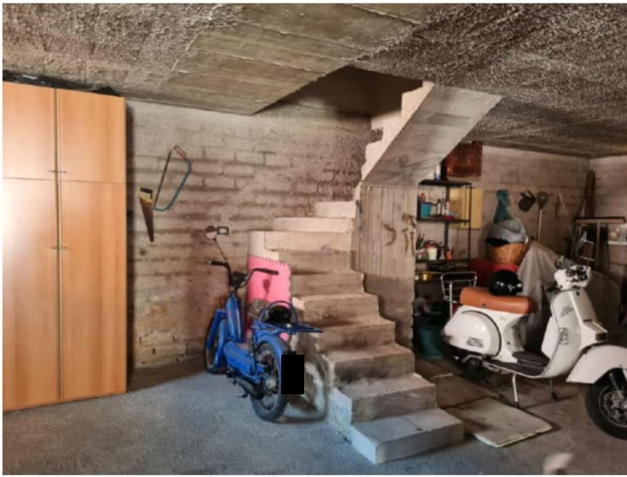
Scala d'accesso al piano rialzato dal Garage
