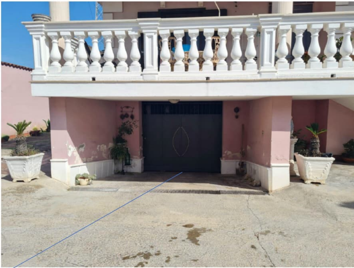
Rampa di accesso al garage
