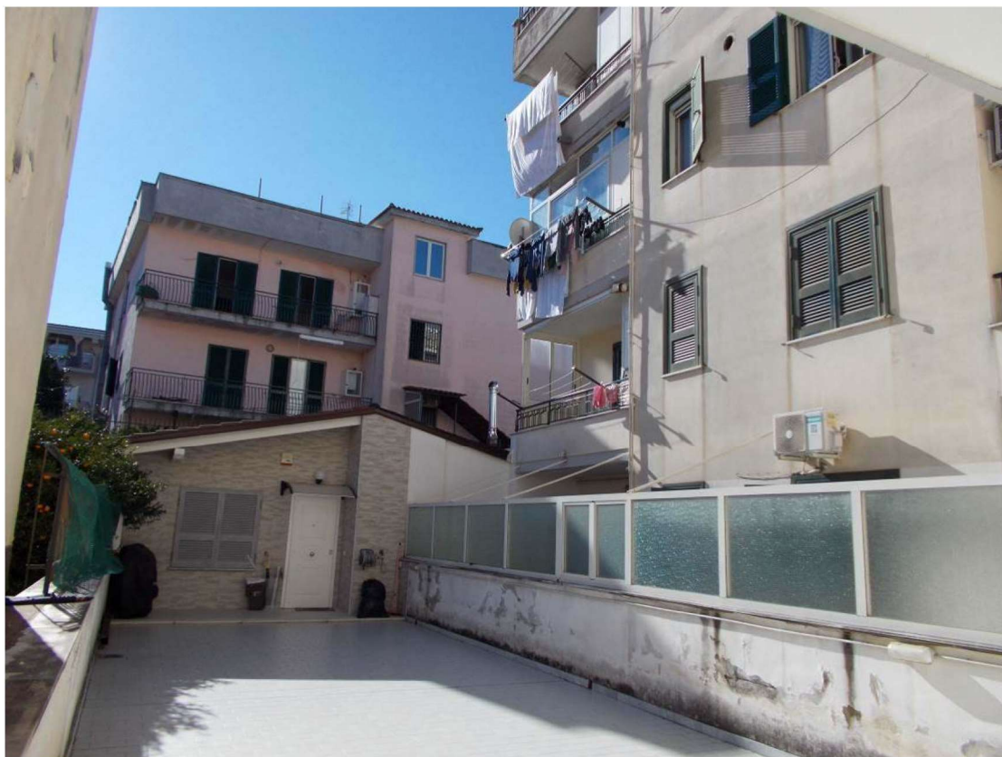
Foto 05 – L'ingresso al sub 52 dall'area comune
