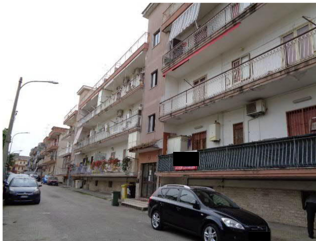
Veduta esterna del fabbricato da via L. Pirandello
