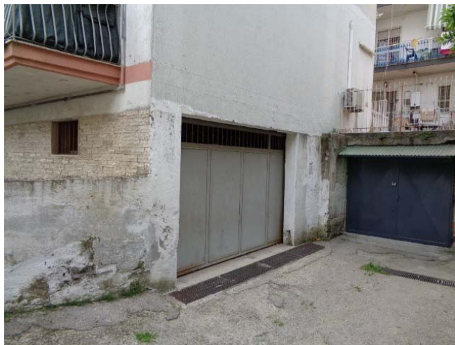
Porta metallica d'accesso al locale Box Auto
