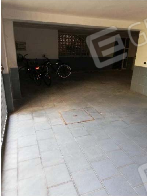
LOCALE DI SGOMBERO 1 S1
