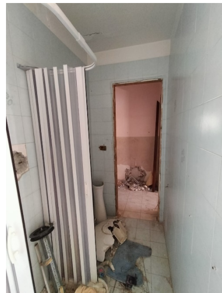
Bagno 1, veduta corridoio
