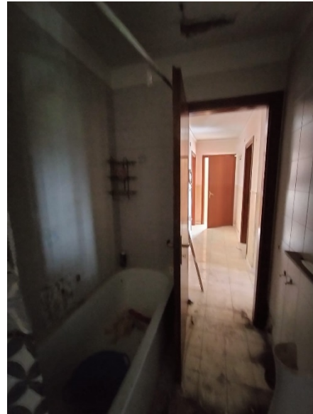
Disimpegno veduta lato Ovest
