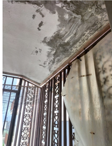
Balcone lato Ovest
