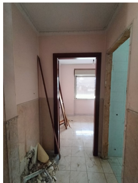
Disimpegno veduta lato Ovest
