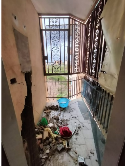
Balcone lato Ovest
