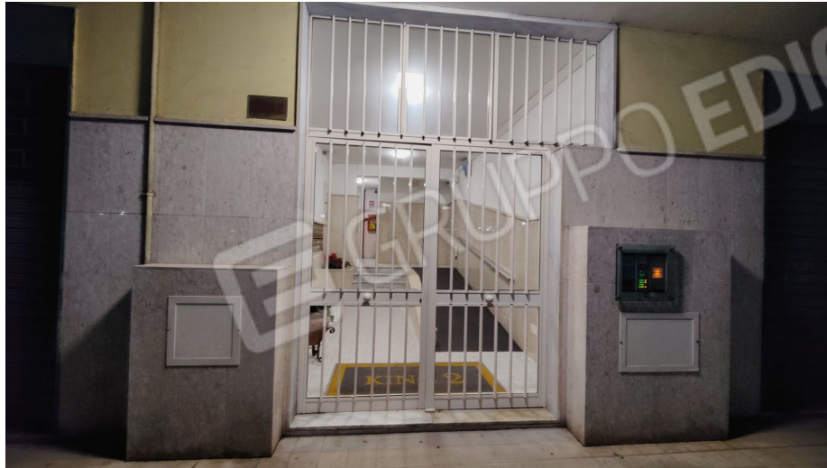
Foto n. 5: Ingresso pedonale fabbricato
