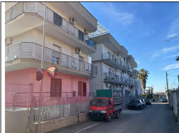
Fotografia n. 1 _ Prospetto su via del Noce, con evidenziazione dell'immobile di interesse
