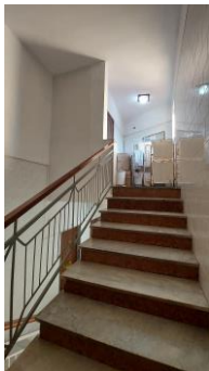
Scala accesso cespite
