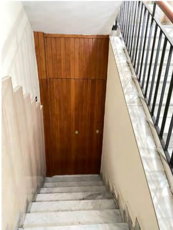
Fotografia n. 5 _ Portoncino tra il secondo ed il terzo piano sulla scala comune
