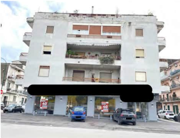
Fotografia n. 1 _ Prospetto su via Sannitica
