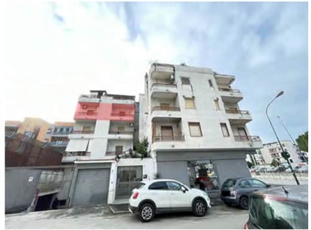
Fotografia n. 2 _ Prospetto su via della Libertà con individuazione del LOTTO UNICO
