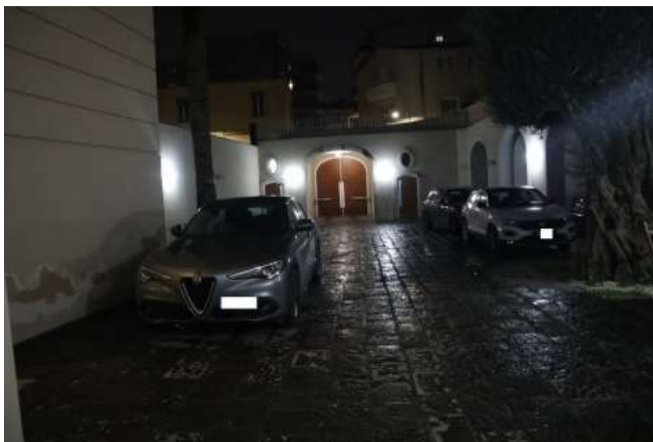
FOTO 1 - 2 - 3 - 4 Viste esterne del fabbricato
