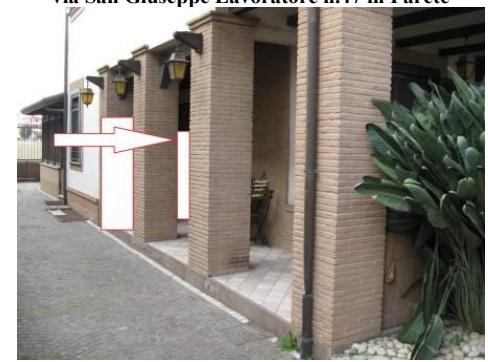
Figura 9 cortile comune con accesso al porticati dell'appartamento al piano terra interno 1
