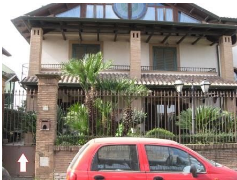
Figura 6 facciata est del fabbricato alla via San Giuseppe Lavoratore n.47 in Parete
