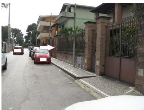
Figura 3 Accesso all'immobile da via San Giuseppe Lavoratore n.47 – Parete
