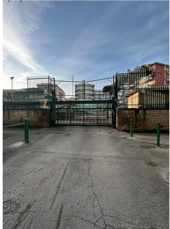
Foto n.3 – particolare ingresso area di suolo
