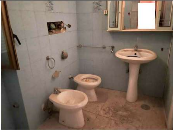
Servizio igienico piano terra
