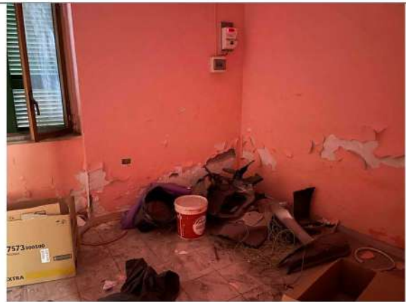
Interno vano terraneo
