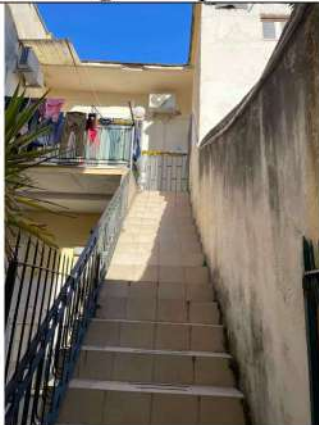
Scala esterna di collegamento
