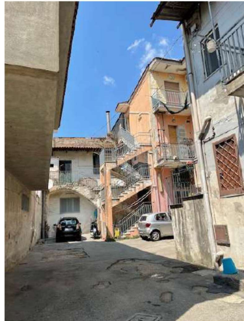
Fig. 2. Vista del cortile, del fabbricato e della scala.
