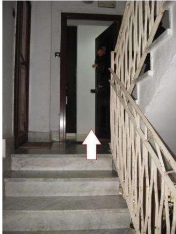
Figura 10 accesso all'appartamento pignorato
