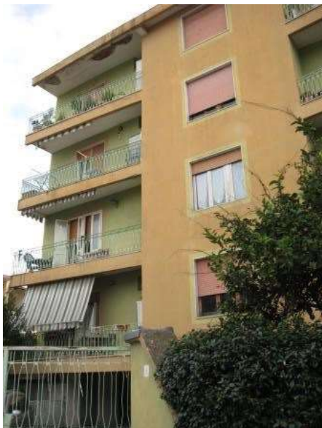
Figura 6 facciata est del Condominio Barbato alla via degli Abeti n.8 in Aversa
