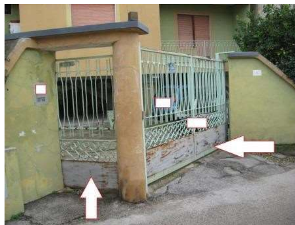
Figura 4 Facciata Nord su via Colonne n.133 – Giugliano in Campania
