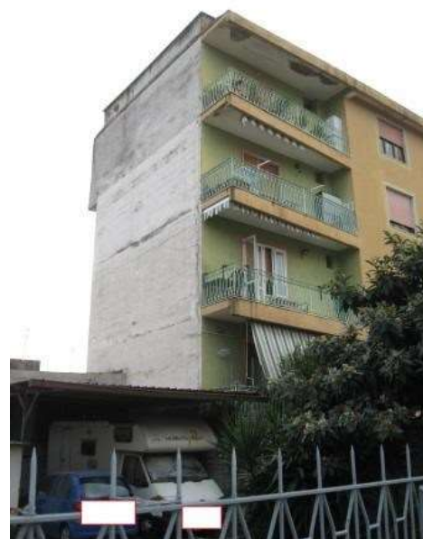
Figura 7 facciata nord/est del Condominio Barbato alla via degli Abeti n.8 in Aversa
