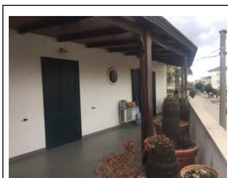
Immagine n. 27 – balcone 4 + tettoia
