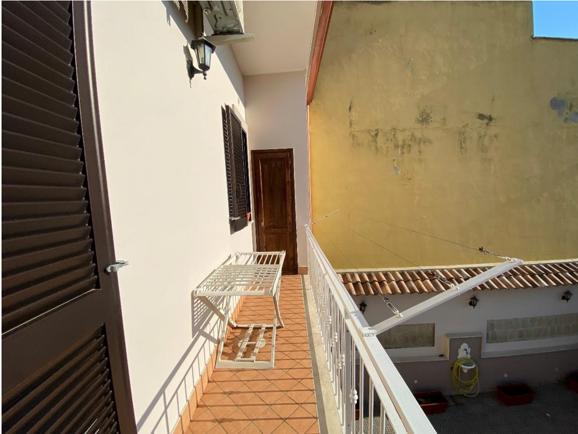
Balcone 2/terrazzo piano primo sub. 4 - lotto 2-
