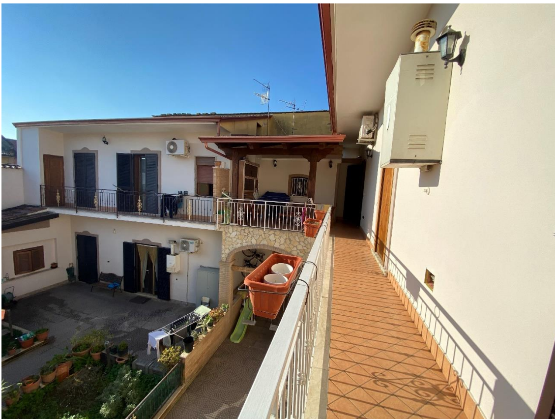
Balcone 2/ terrazzo piano primo sub. 4 lotto 2
