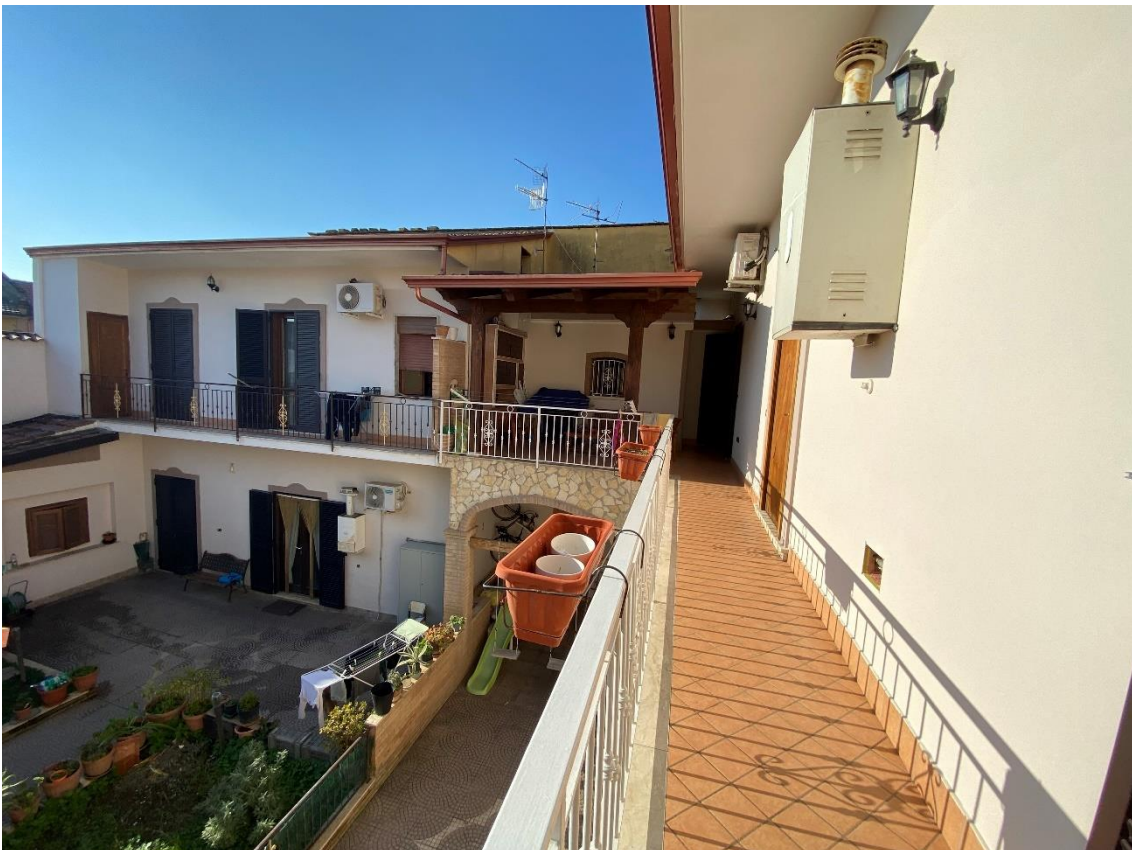
Balcone 2/ terrazzo piano primo sub. 4 lotto 2
