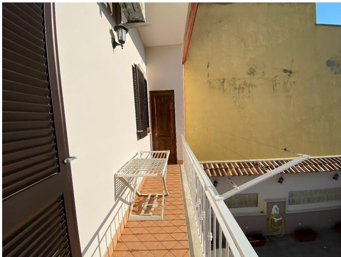
Balcone 2/terrazzo piano primo sub. 4 - lotto 2-
