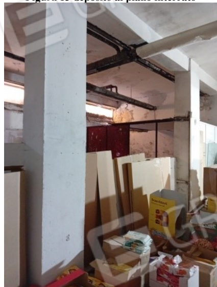
Figura 15 deposito al piano interrato
