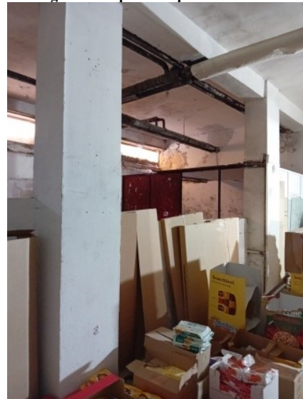
Figura 15 deposito al piano interrato
