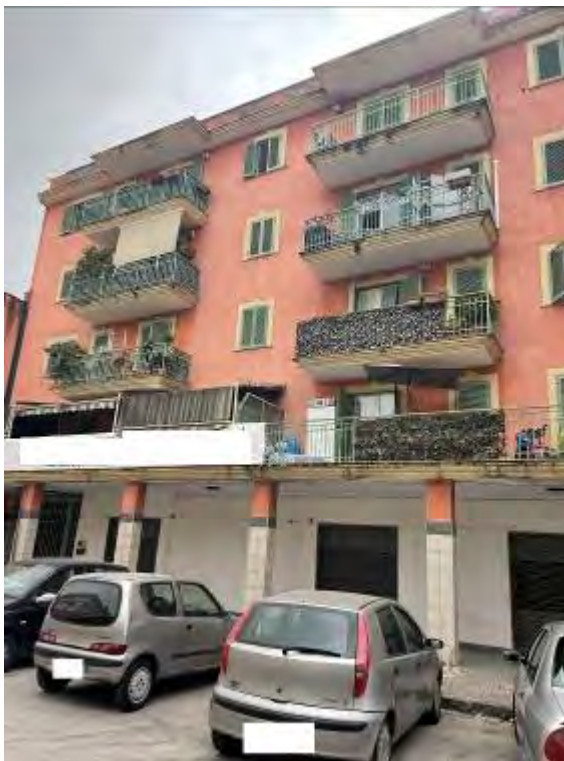
Fotografia n. 1 _ Prospetto del fabbricato su via Matteotti
