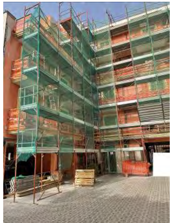
Fotografia n. 2 _ Prospetto del fabbricato sulla corte
