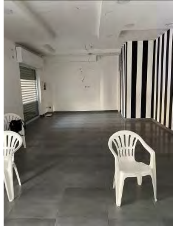
Fotografia n. 6 _ Interno del locale commerciale
