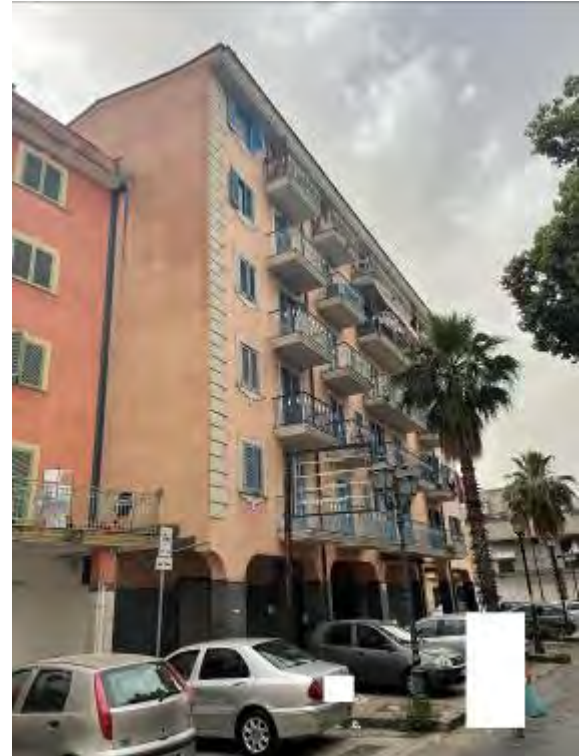
Fotografia n. 2 _ Particolare prospetto su via Matteotti
