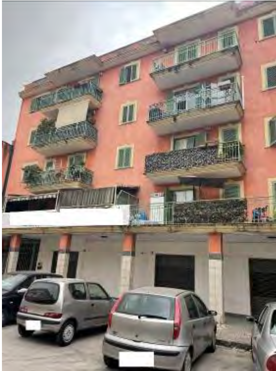
Fotografia n. 1 _ Prospetto su via Matteotti
