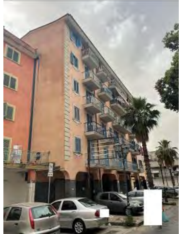
Fotografia n. 2 _ Particolare prospetto su via Matteotti
