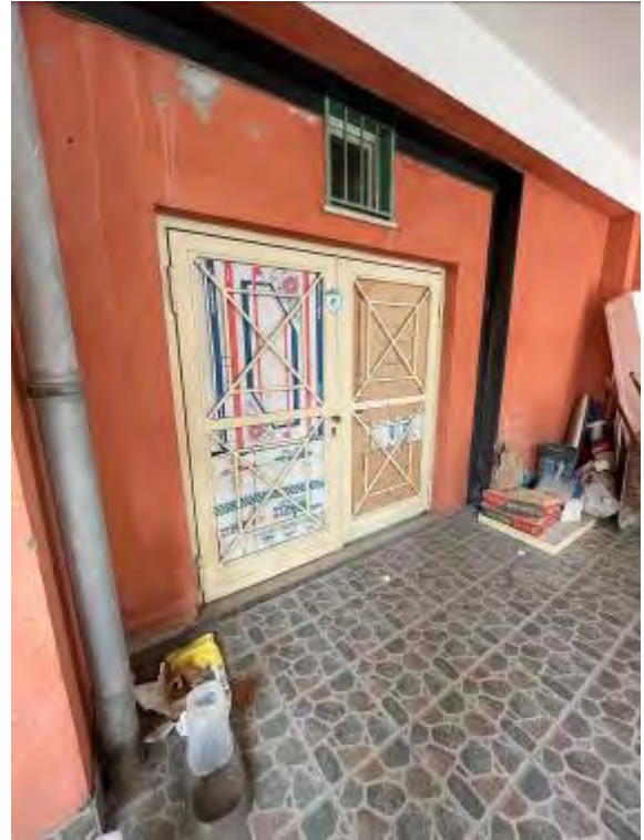
Fotografia n. 4 _ Ingresso al sub 36
