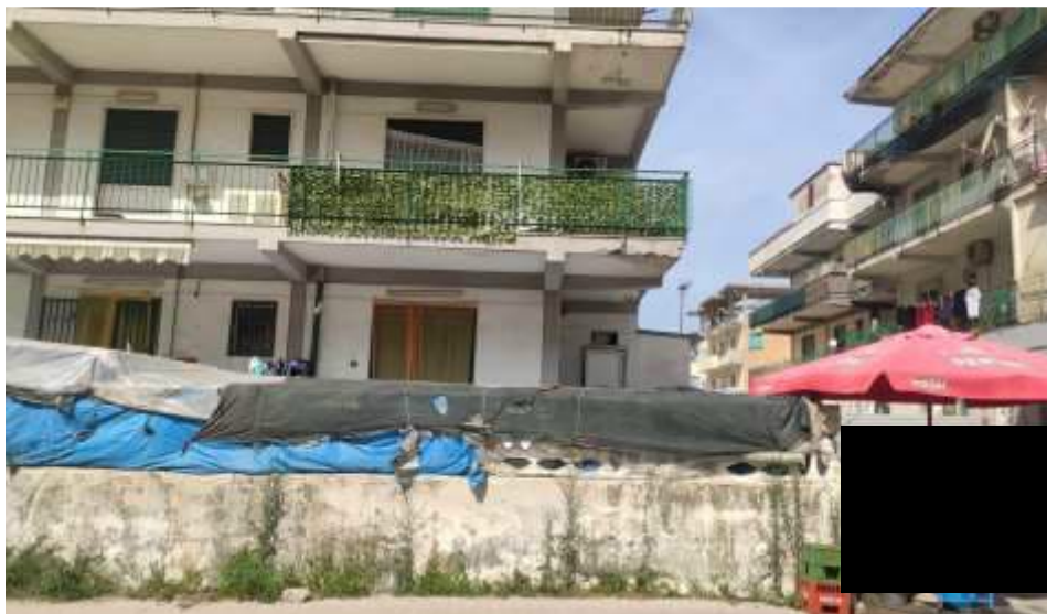
ALTRA VISTA DEL FABBRICATO
