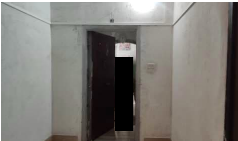
VISTA DELL'INGRESSO ALL'UNITÀ DAL VANO SCALA A
