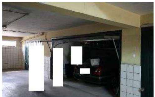
Viste esterne del garage
