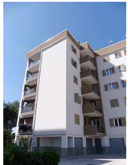
_immagini esterne – via Barbato
