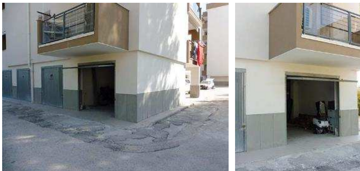
_immagini esterne – accesso al box auto
