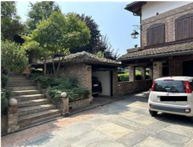
Vista Dal Piazzale di ingresso
