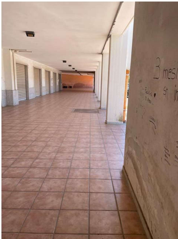
Foto 18 – Capannone – Porticato sovrastante (botola)
