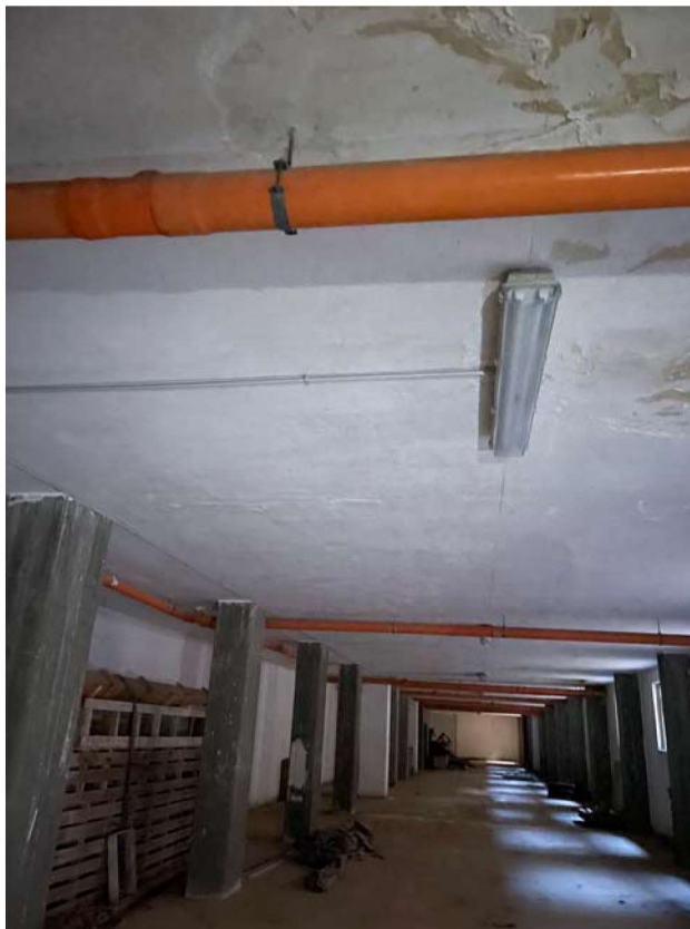
Foto 16 – Particolare infiltrazioni
