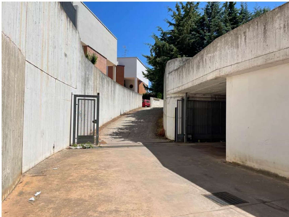
Foto 7 – rampa e accesso visti dall'interno
