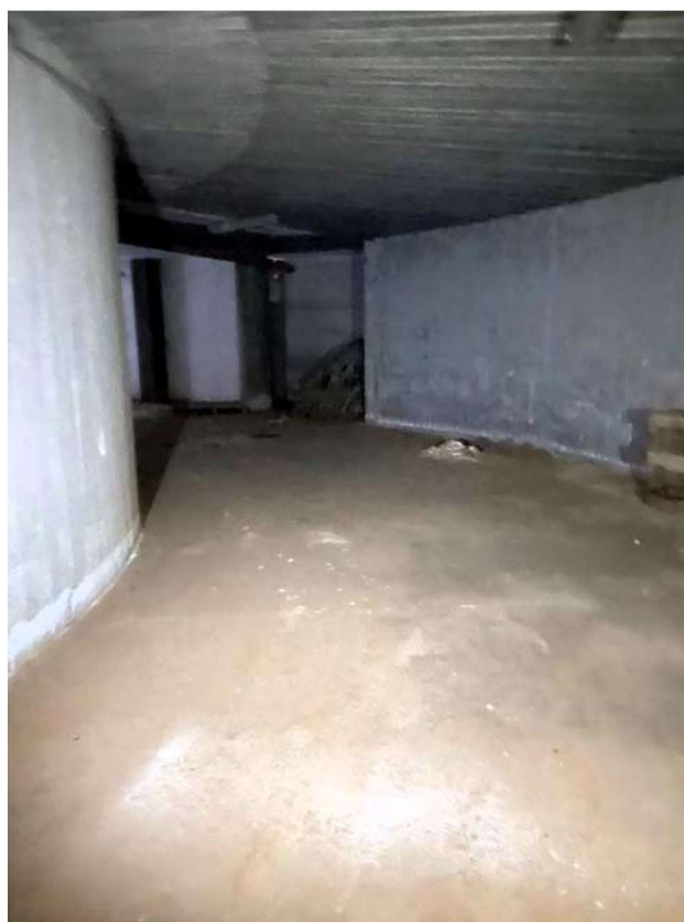
Foto 10 – Porzione circolare (ingresso)
