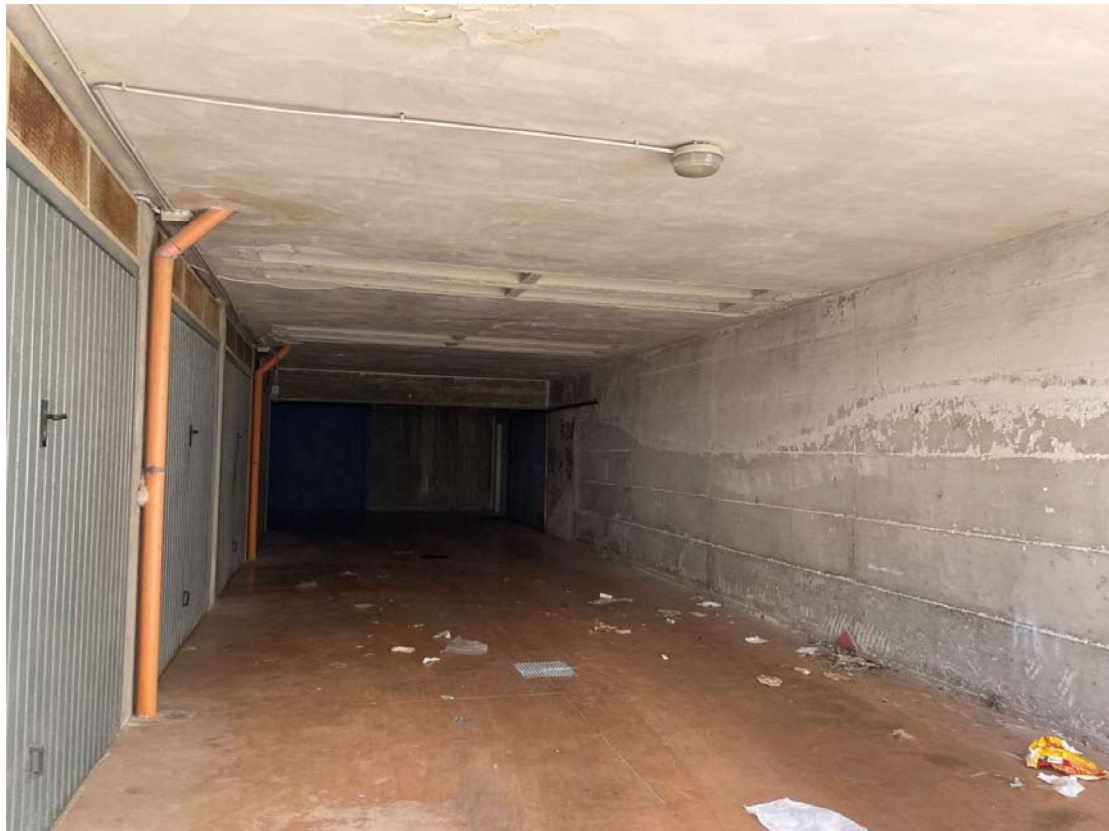
Foto 8 – corsia di manovra
