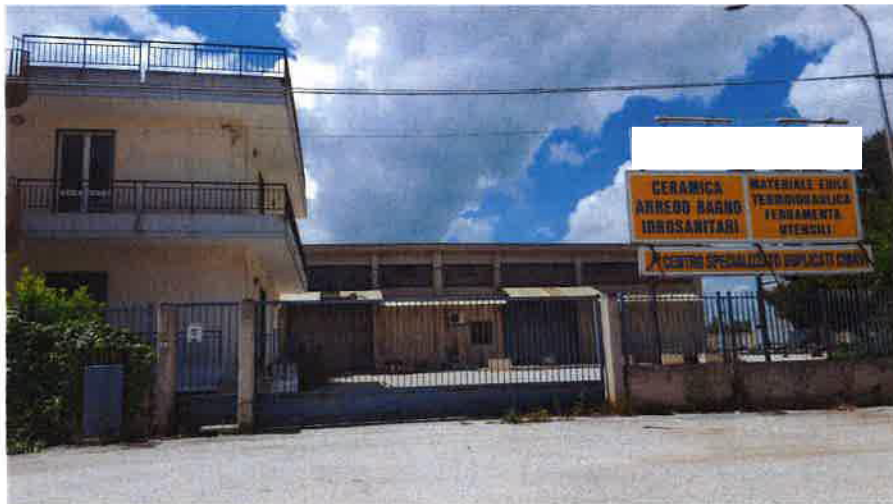
Vista di insieme dall'ingresso della intera area
