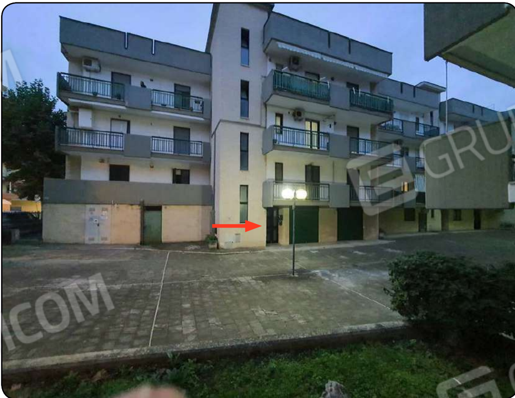
Foto 2: Prospetto est del fabbricato sulla corte interna scoperta del complesso condominiale in via Enrico Toti civ. 26, Cassano delle Murge, Bari, con indicazione del portone d'ingresso della scala A
