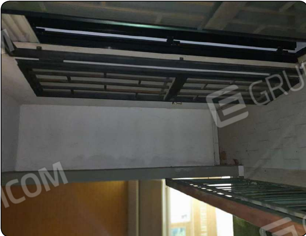
Foto 12: Balcone n.2 prospiciente via Enrico Toti
