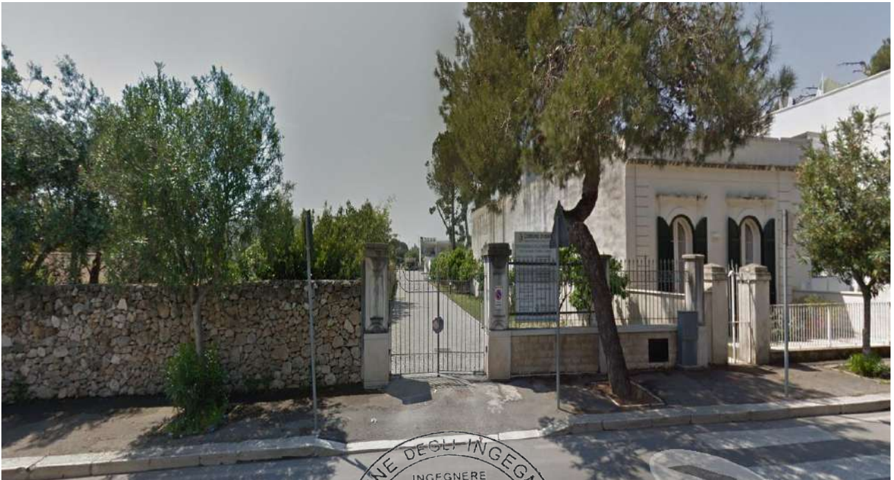
foto n.01 – Ingresso Carrabile – via Bari
